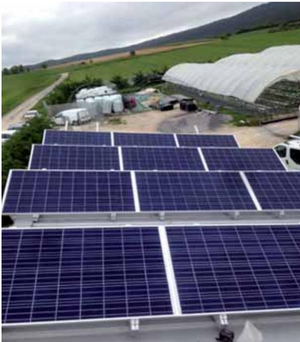
◀ Instalación fotovoltaica aislada en invernadero de fresas, 100% autónoma (toda la energía consumida en la explotación proviene del sol)
