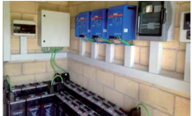
Instalación fotovoltaica aislada para bombeo solar, 100% autónoma (Toda la energía utilizada para el bombeo proviene del sol) ▶
